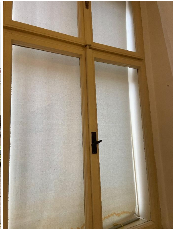
Okno č.4 – původní mosazná klička na horní okně a nepůvodní kličky na spodních oknech
