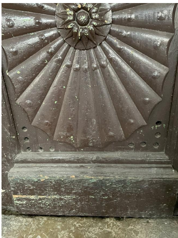
Pohled na střední část vrat včetně průduchů v pravé výplni
