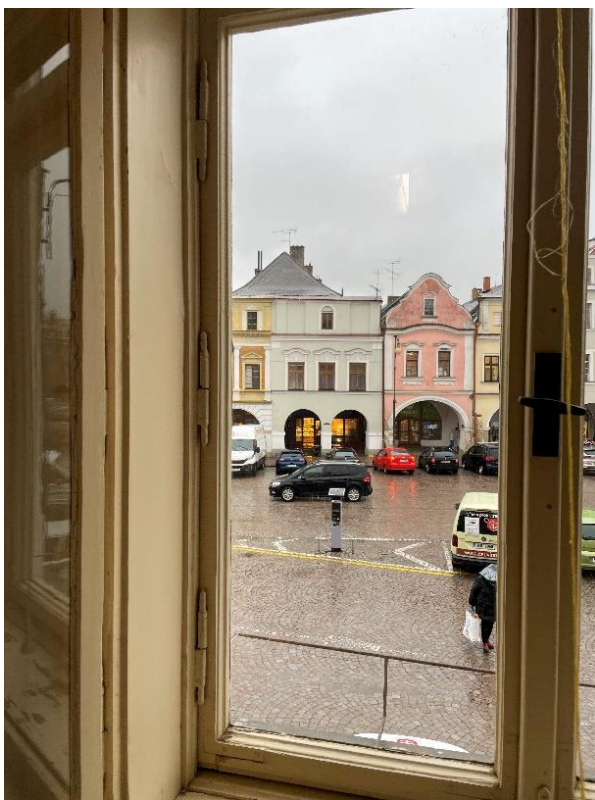
Okno č.4 – původní mosazná klička na horní okně a nepůvodní kličky na spodních oknech
