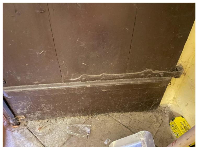
Pohled na vnitřní část dveří – závěsy na pravé půlce dveří
