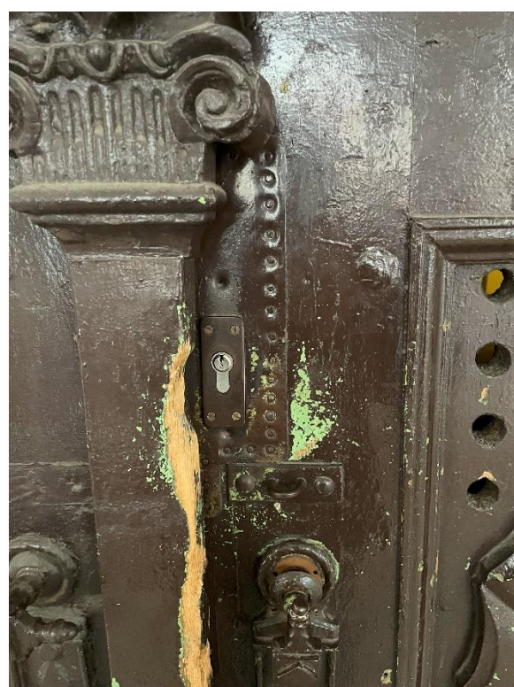
Pohled na vnější část dveří – původní kliky a přidaný zámek FAB
