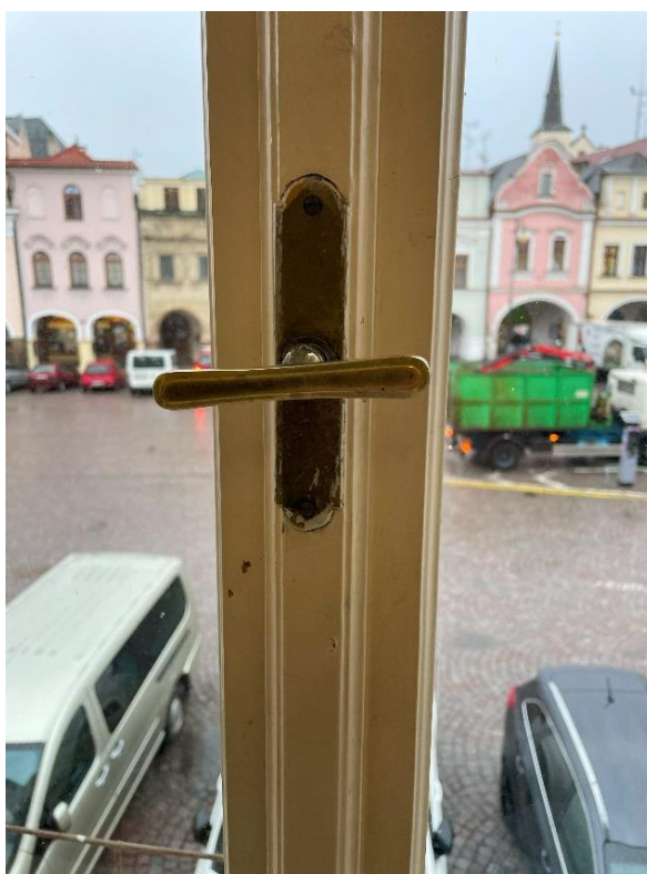
Okno č.1 – nepůvodní hliníková klika na vnitřním okně a původní mosazná klička na vnějším okně
