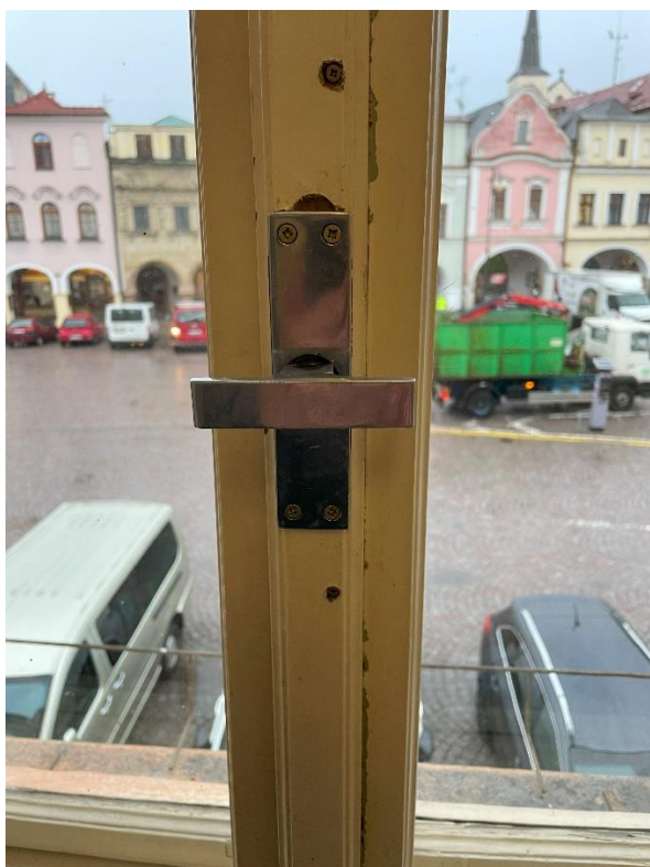
Okno č.1 – nepůvodní hliníková klika na vnitřním okně a původní mosazná klička na vnějším okně
